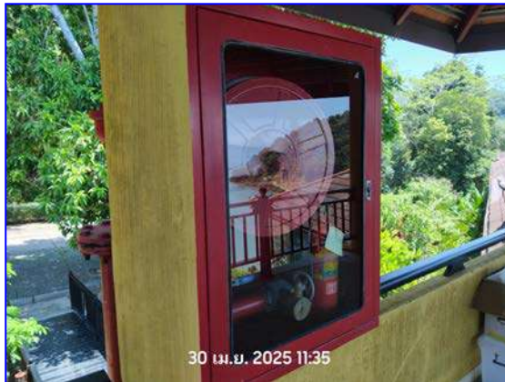
รูปที่ 2.20 ตู้สายฉีดน้ำดับเพลิง และถังดับเพลิง
