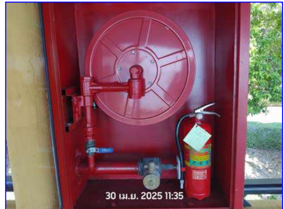
รูปที่ 2.20 ตู้สายฉีดน้ำดับเพลิง และถังดับเพลิง
